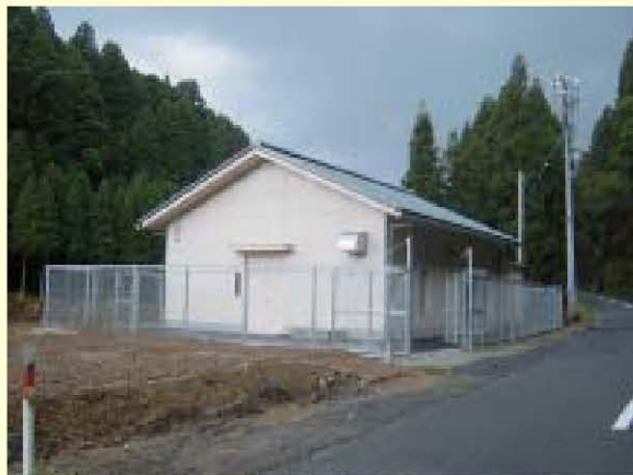
森配水ポンプ場
