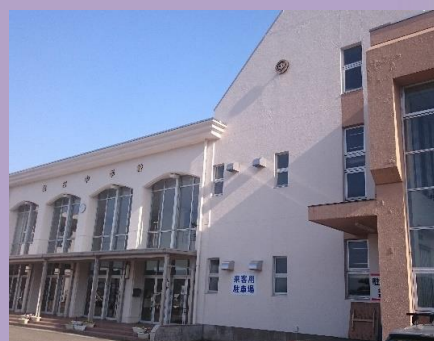
各小中学校改修(外壁補修など)
