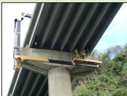
橋梁点検車による橋梁下面の点検
