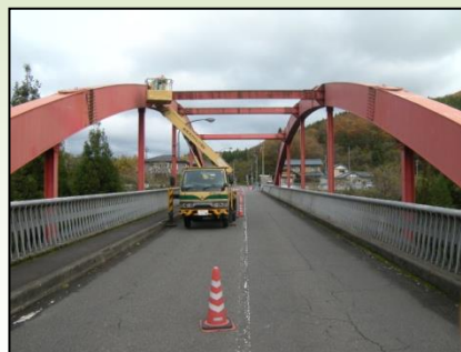
高所作業車による橋梁上面の点検
