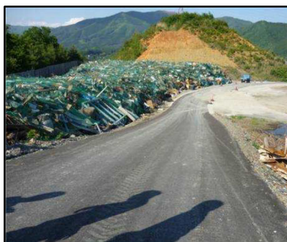
ネットで覆われた災害廃棄物 (飛散防止策)
