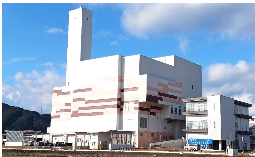
鯖江クリーンセンター(ごみ焼却施設)
